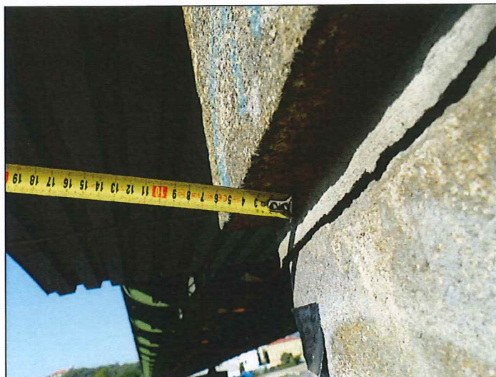
Obr. č. 10 – Opěra O 01 – úložný práh – vysunutý kvádr vlevo
