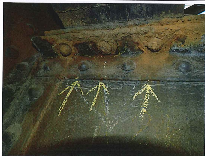
Obr. č. 2 – Konstrukce K 01 – podélník č. 4 – volné nýty pod 7. mostnicí
