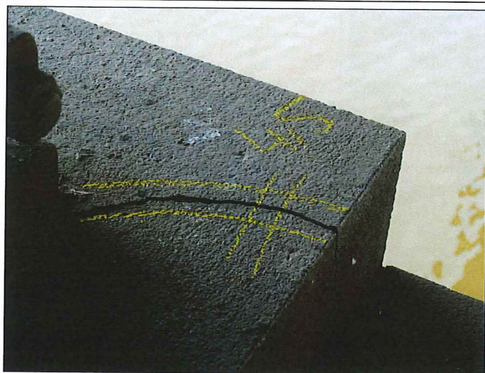
Obr. č. 13 – Pilíř P 02 – úložný práh – prasklý kvádr vlevo
