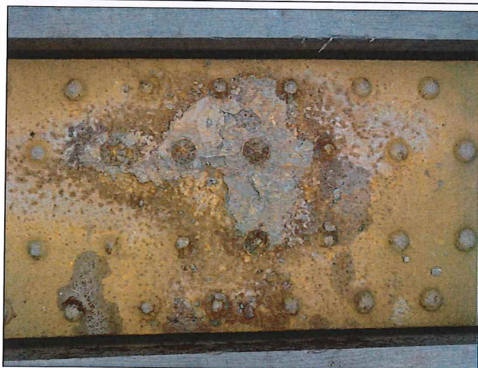
Obr. č. 8 – Konstrukce K 03 – příčník – oslabení horní pásnice
