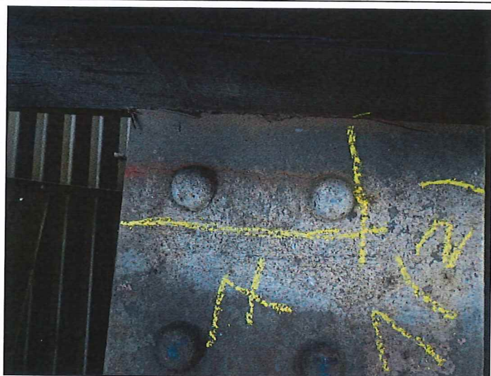
Obr. č. 1 – Konstrukce K 01 – podélník č. 4 – trhlina v horní pásnici mezi 6. a 7. mostnicí
